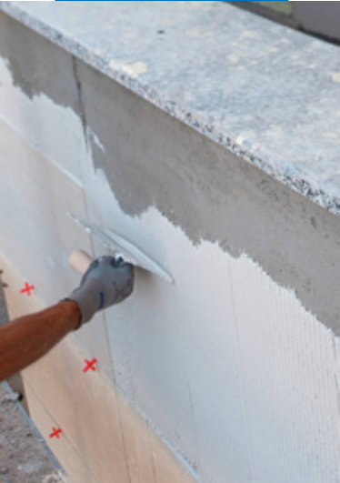
Fektetés homlokzatra: ragasztó felvitele az alapfelületre
