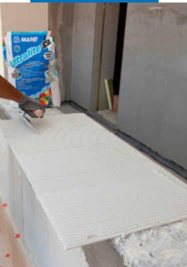
A ragasztó felhordása a burkolólap hátoldalára
