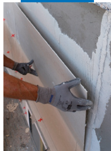
Vékony porcelán burkolólap ragasztása homlokzatra
