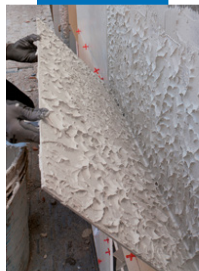
Burkolólap teljes hátoldali fedettségének ellenőrzése homlokzaton
